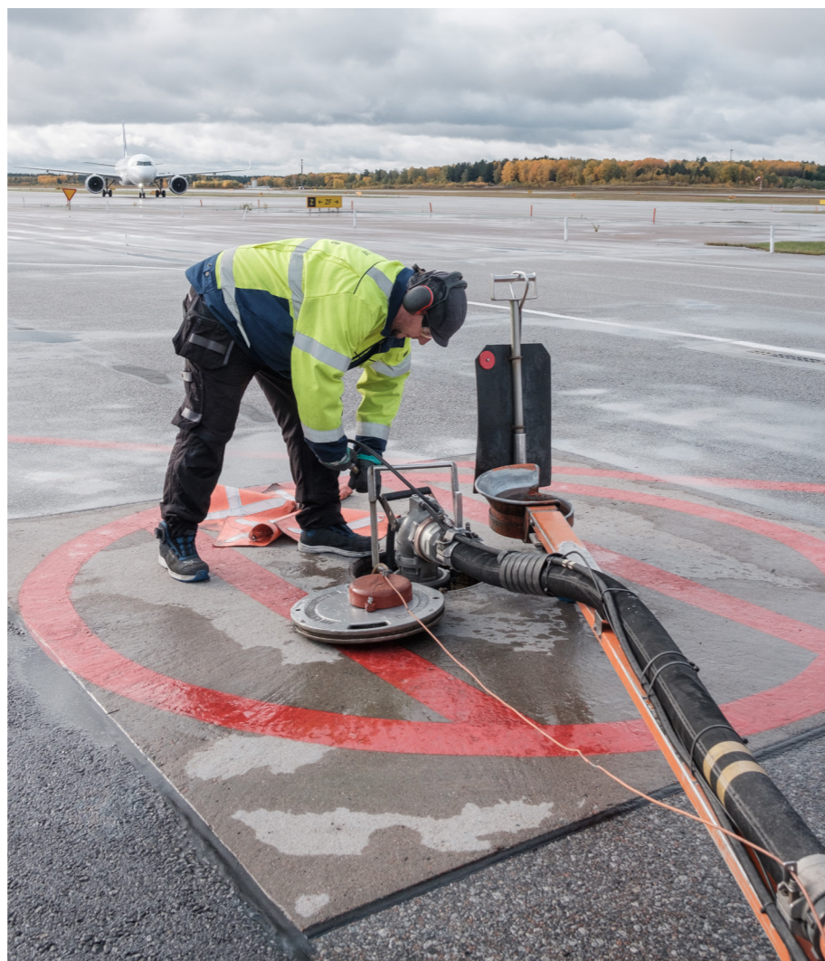
Magnus Albertsson ska koppla i slangen till bränslesystemet.
